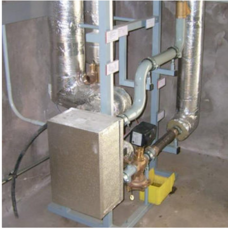
Abb. 42: Wärmeübergabestation
