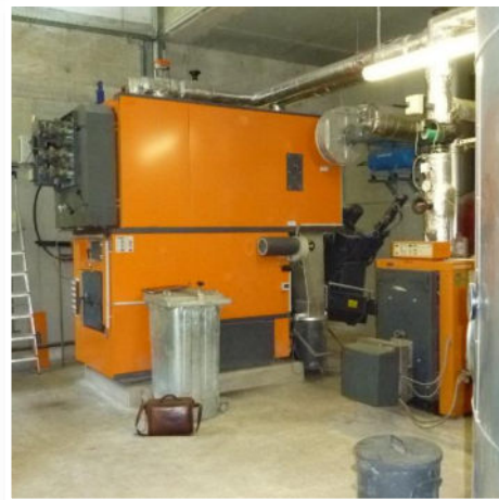
Abb. 39: Holz-Hackschnitzelkessel
